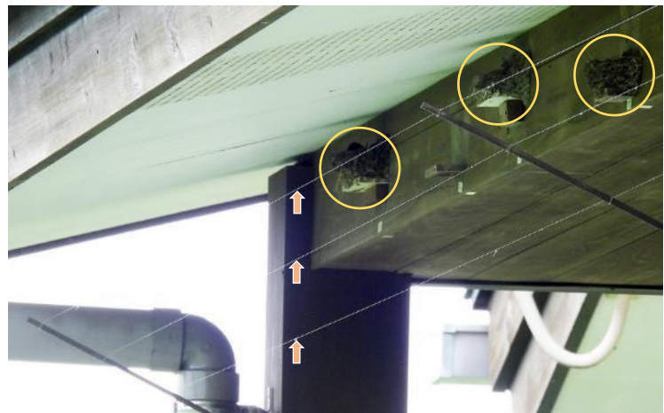
カラス除けの糸(↑) 約20cm間隔で3本を設置奥にツバメの巣(○)。ツバメは支障なく糸の間を飛び回る
