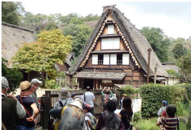
築 200 年の合掌造りの古民家。茅葺きの急勾配の屋根に注目して観察
