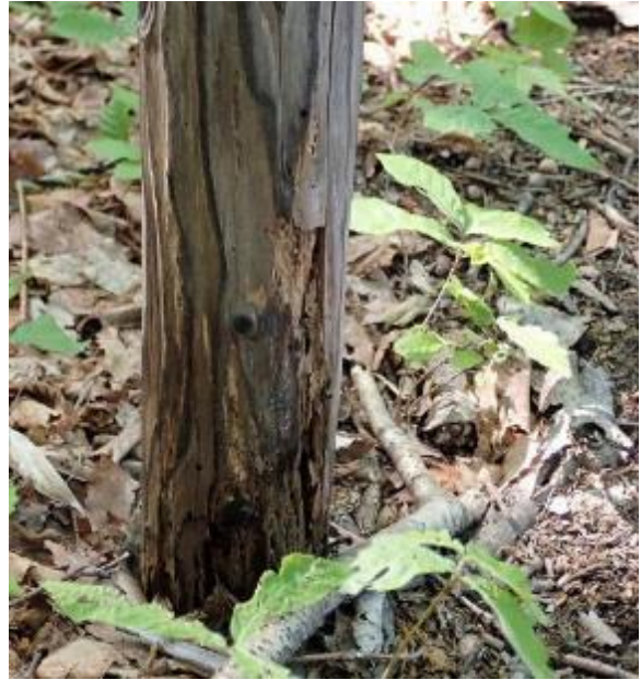
杭の基部の拡大
